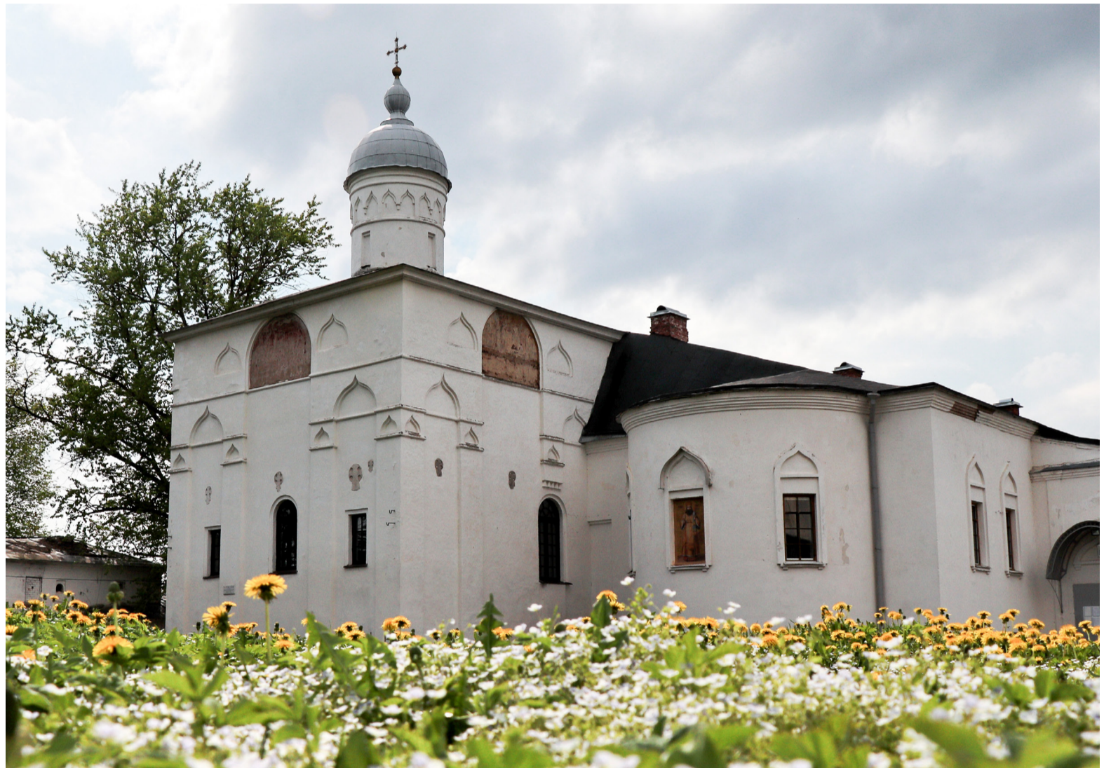
● В Антониевом монастыре идёт ремонт кровли Церкви Сретения Господня, следующий этап — ремонт фасадов
